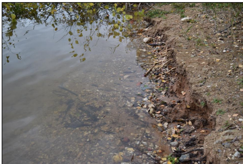
Рис. 3. Берег Озернинского водохранилища представляет собой подмываемый бенч, в уступе вскрываются отложения московской морены (валунный суглинок). Линия уреза выложена грубообломочным материалом преимущественно древесно-галечной размерности
